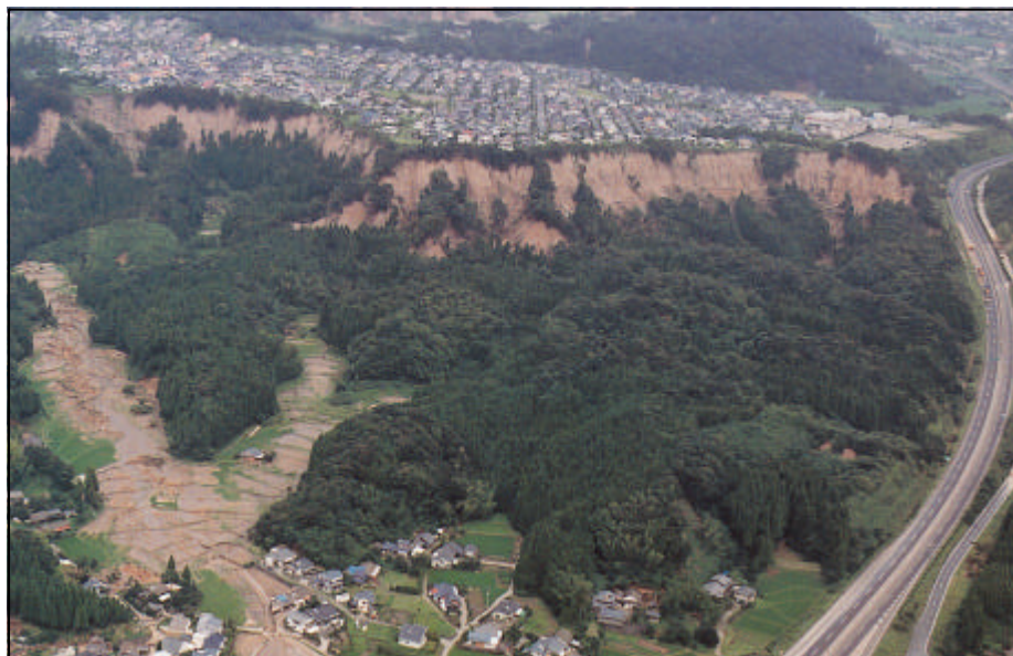
あいら （鹿児島県始良町：平成5年の集中豪雨等による被災状況）
