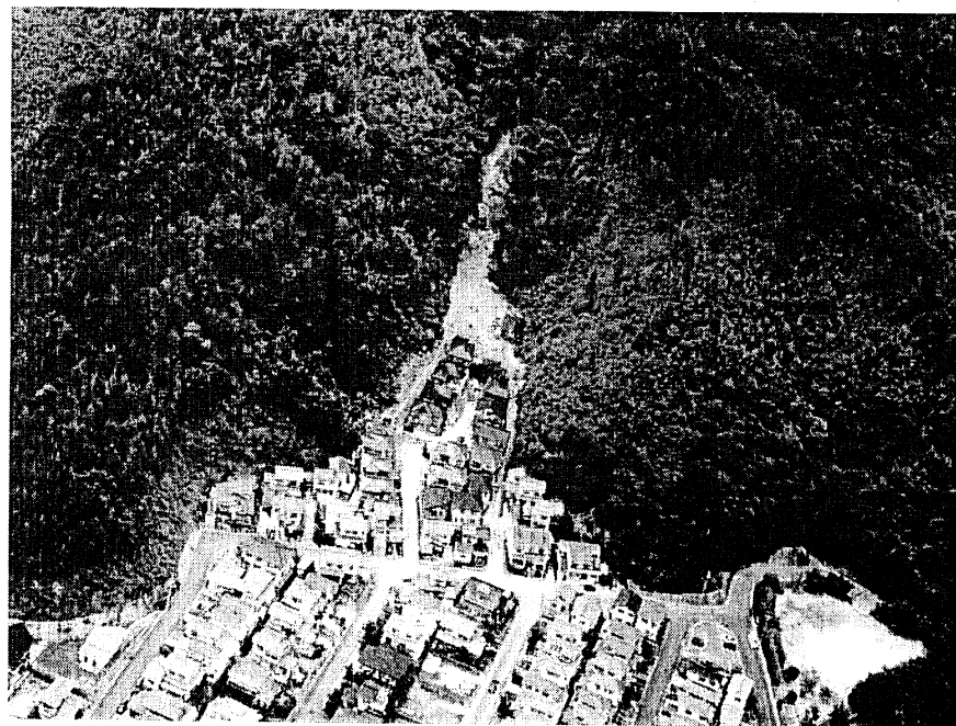
（広島県広島市：平成11年の豪雨災害による被災状況）
