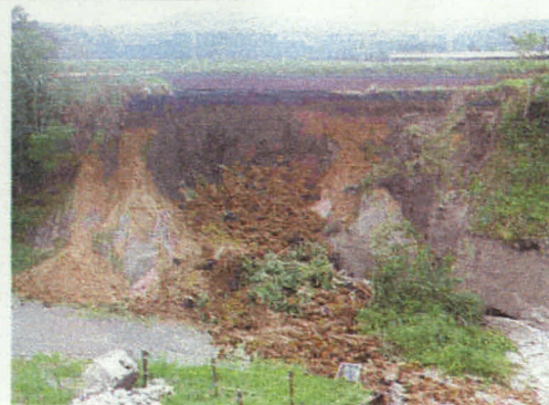
降雨による法面崩壊
