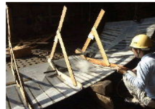
ガス切断 実習
