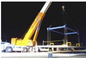
基本施設の改良 (破損したPC版の取替え)
