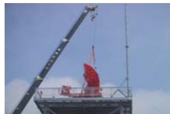
航空保安施設等の改良 (老朽化したレーダーの交換)
