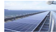
太陽光発電設備
