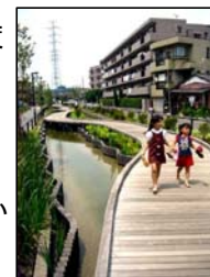
下水処理水を活用したせせらぎ整備(神奈川県川崎市)
