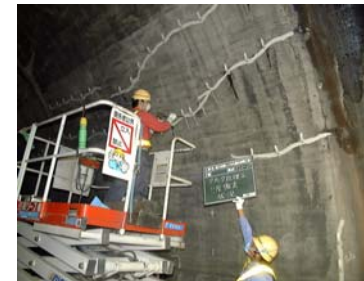
ひび割れの補修
