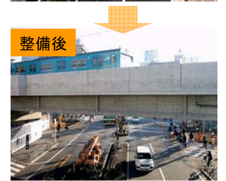
ボトルネック踏切11箇所の解消 (1箇所あたり約5千トン削減)
