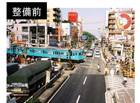
ボトルネック踏切等の対策事例 JR阪和線連続立体交差事業(大阪市)
