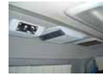
車内冷房設備
