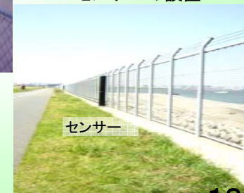
センサーの設置
