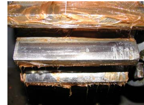
劣化したゲート開閉装置のギヤ
