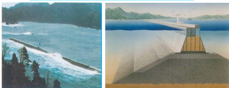
釜石港 湾口防波堤
