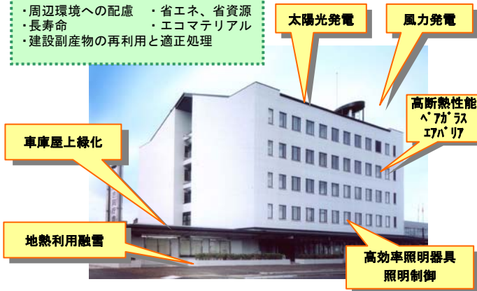
東北地方における初めてのグリーン庁舎(本荘地方合同庁舎外観図)
