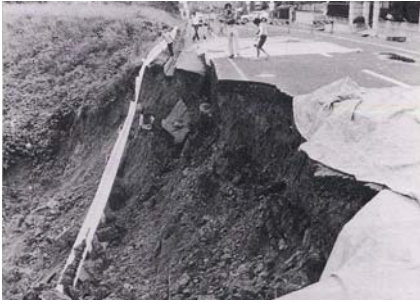
(宮城県沖地震により寸断された幹線道路(仙台市))
