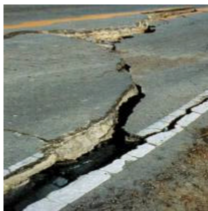
臨港道路(平面部)の被災状況
