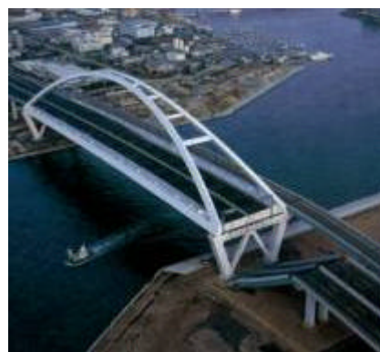
橋梁の被災状況
