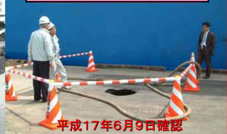
3号岸壁 陥没状況
