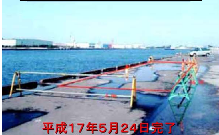
2号岸壁 復旧状況
