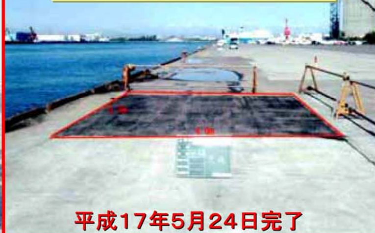
3号岸壁 復旧状況
