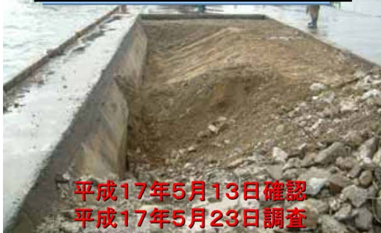
2号岸壁 空洞化状況
