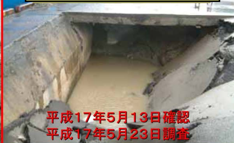
3号岸壁 空洞化状況
