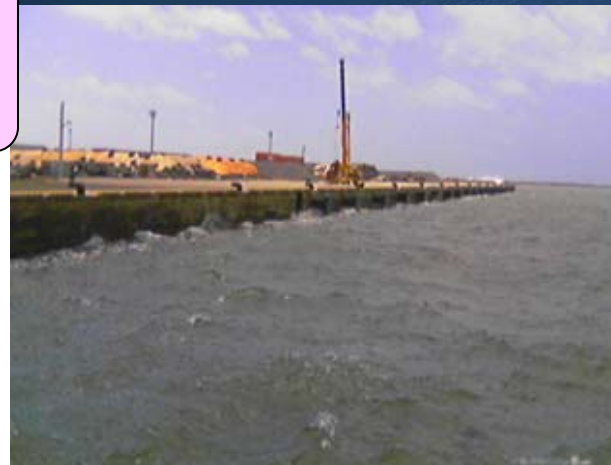
荷役障害が生じている 外港地区
