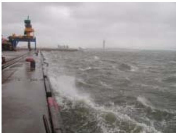
岸壁前面の静穏度が保たれていない例
