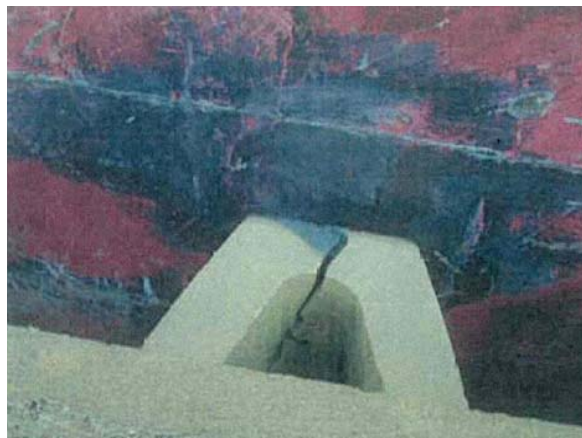
長周期波の影響による船舶、防舷材の破損
