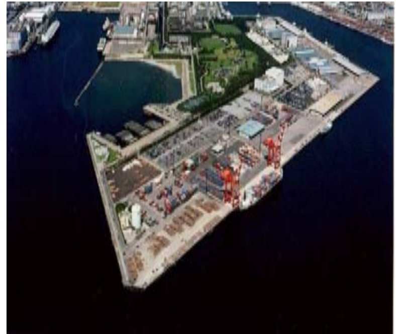
外貿コンテナ・原木・ 自動車輸送
