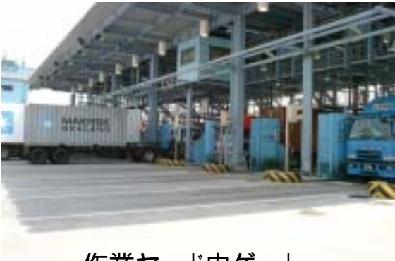
作業ヤード内ゲート
