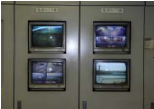
監視室監視モニター
