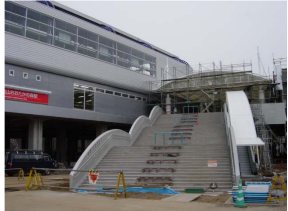
流山おおたかの森駅建設工事現場
