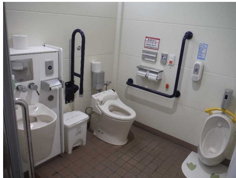
オストメイト施設・こども用施設付きトイレ (「道の駅」 たるみずはまびら)
