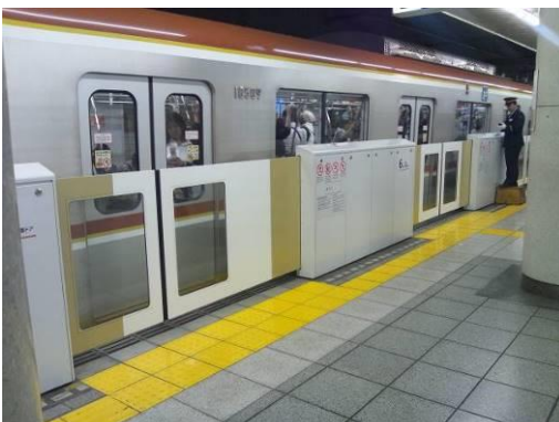
参考 3-1-6 : 可動式ホーム柵（昇降式）の例
