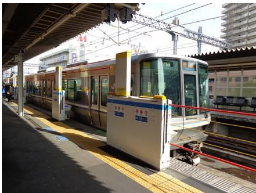
参考 3-1-6 : 可動式ホーム柵（昇降式）の例
