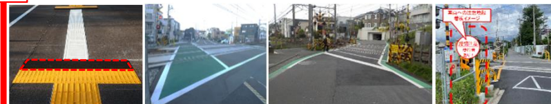
ゴムチップ舗装 カラー舗装 踏切道内の車道外側線 注意喚起看板
