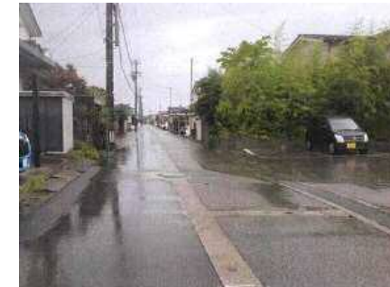
雨水貯留管等の整備後 (令和4年8月(50.5mm/h))
