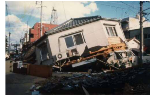
出典: 全国被災建築物応急危険度判定協議会
