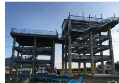
津波避難タワー
