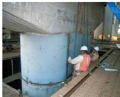
鋼板巻き立てによる補強工事
