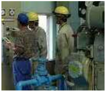
現地で施設の操作
