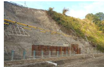
鉄道斜面復旧(大井川本線)
