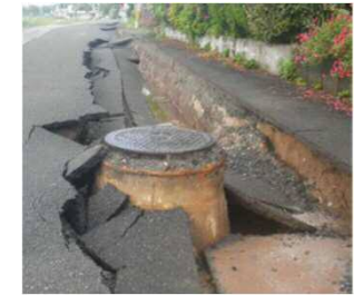
下水道施設（管きよの被災）
