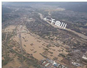
<令和元年東日本台風>
