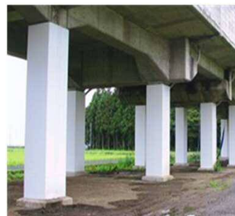
高架橋耐震補強
