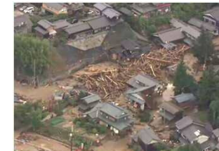
土石流等による被害 (新潟県村上市)
