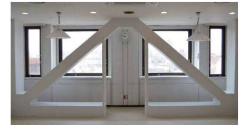
ブレース補強工法
