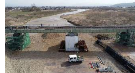
橋梁復旧(磐越西線)
