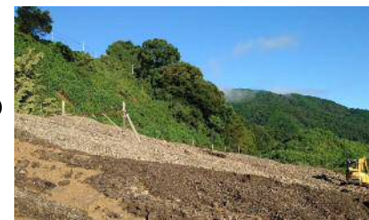
線路への土砂流入(大井川本線)
