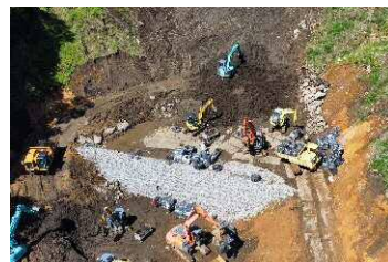
安全対策施工状況
