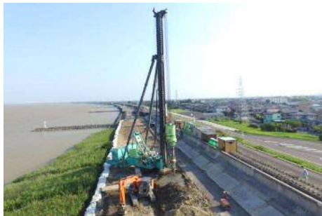
河川堤防の地震対策(木曾川)
