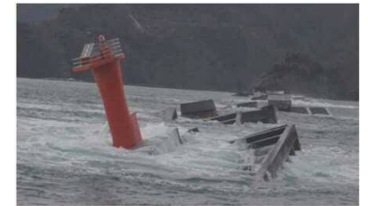
被災した防波堤(釜石港)
