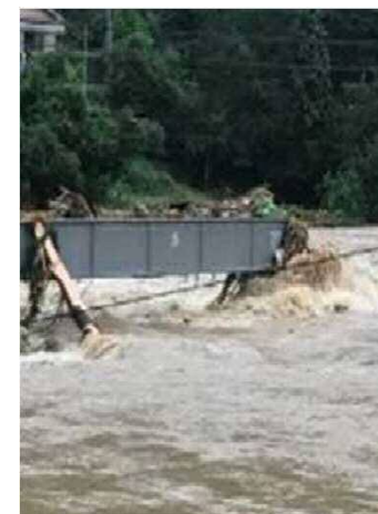
崩壊した橋梁
