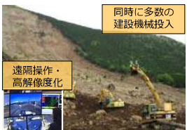
無人化施工（イメージ）
