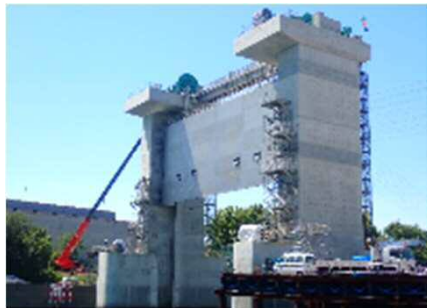
水門(海岸保全施設)の地震・津波対策(和歌山下津港海岸)
