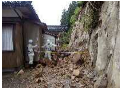
令和5年 石川県能登地方を震源とする地震
