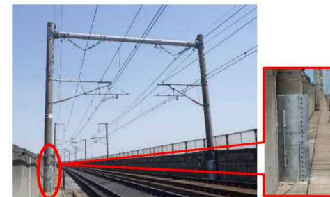
電柱の補強 下部補強
