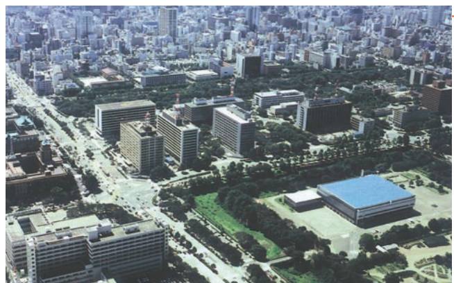
計画的な整備により調和のとれた都市環境を形成 一団地の官公庁施設（名城郭内団地・名古屋市） Formation of a well-balanced urban environment by planned development of integrated government and public office facilities (Government Buildings Cluster, Nagoya Castle Grounds)
