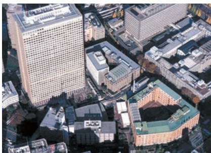
霞ヶ関三丁目南地区の現況 Construction site in Kasumigaseki 3-chome area
