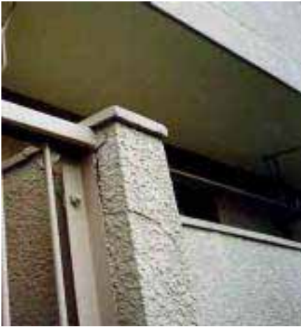
写真4-3 外壁の小修理 施工前
