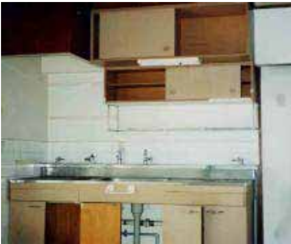
写真4-8 台所流し台 施工前
