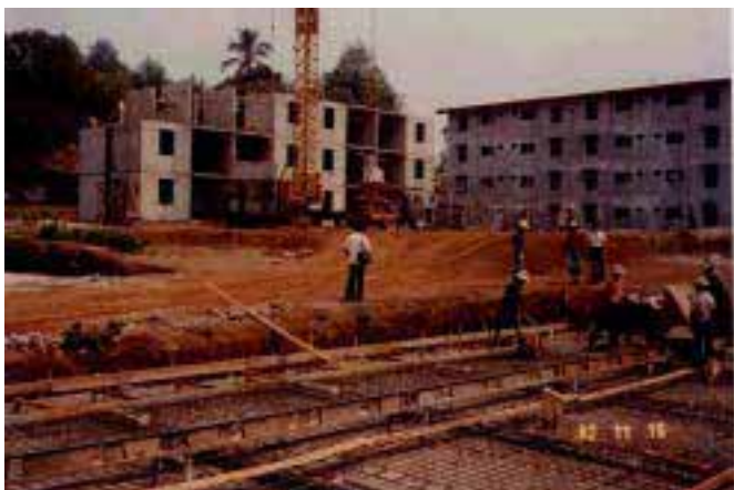
写真2 - 13 1980年代初期のプレファブ工法により モデル中層住宅(インドネシア)
