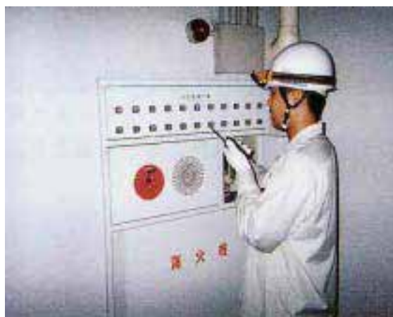
写真4 - 2 火災報知点検
