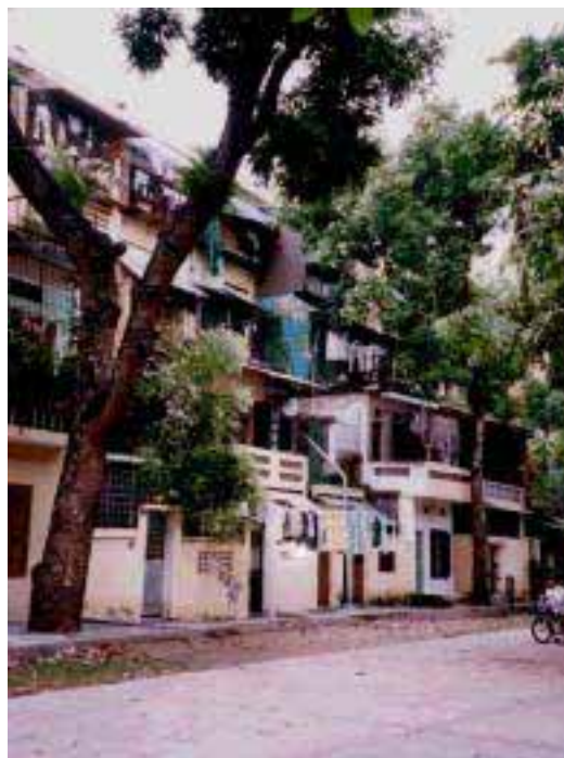
写真2 - 14 1960年代のRCラーメン+レンガに よる中層集合住宅(ベトナム Kim Lien 団地)
