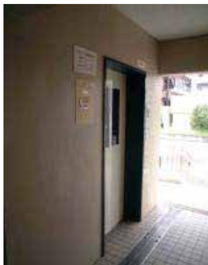
写真4 - 14 EV入口廻り
