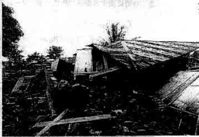
写真14 平屋建て住宅の崩壊
