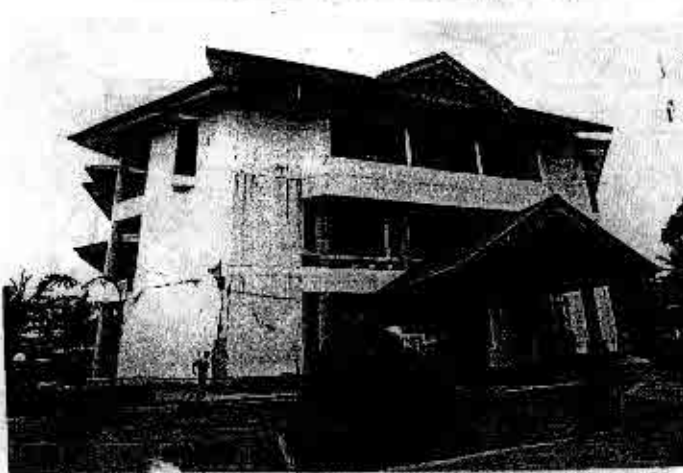
写真 6a 3階建てRC造オフィスの外観
