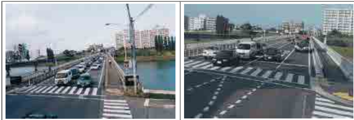
写真 4.2.1-4 有明大橋（新潟市）状況 拡幅事業前(左)、拡幅事業後(右)
