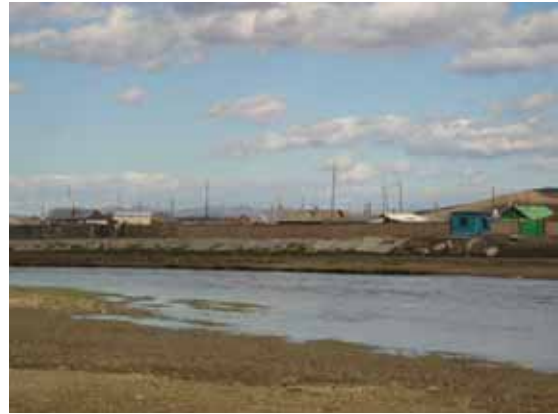
ハラ川と護岸工(奥はダルハン市街、対岸の護岸工はダルハン市によって建設された)
