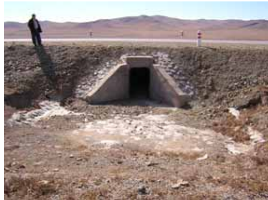
東部地域道路横断排水施設 (現地施工業者実施)
