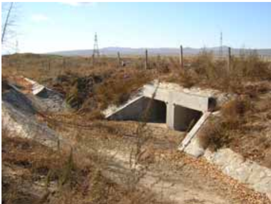
モンゴル鉄道横断排水施設(ダルハン市付近) (日本の無償援助で建設)
