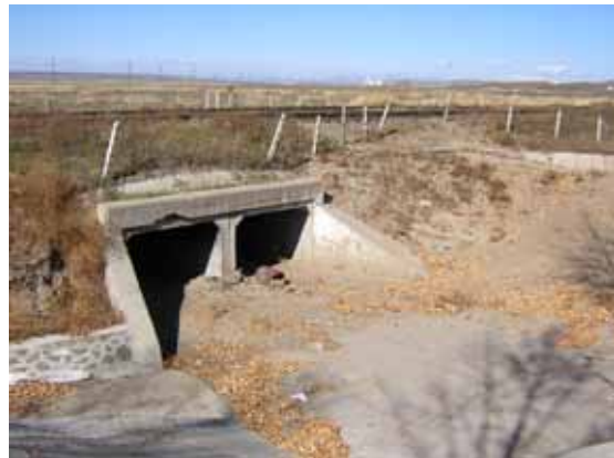
モンゴル鉄道横断排水施設(ダルハン市付近) (モンゴル鉄道が過去に建設)
