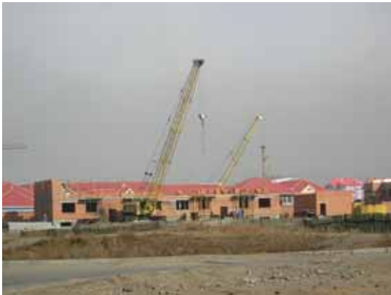
ウランバートル市内新規住宅建設風景 (市内南西部)
