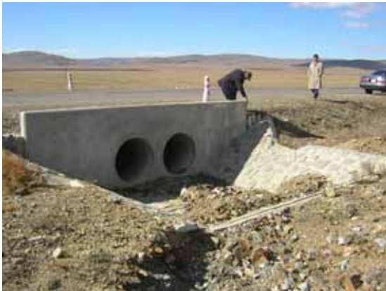
東部地域道路横断排水施設 (日本の無償援助で実施)
