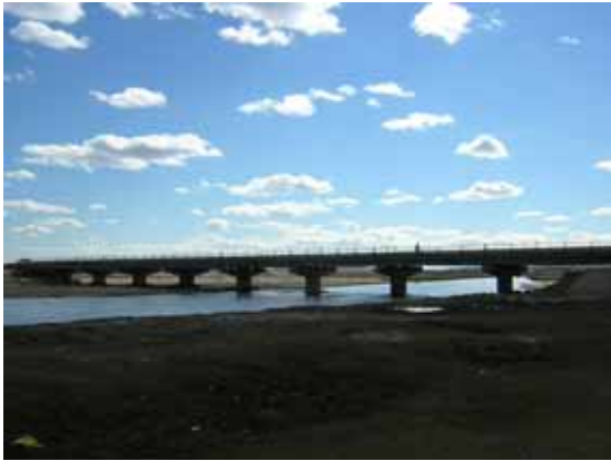
ハラ川と道路橋 (道路橋はダルハン市によって建設された)
