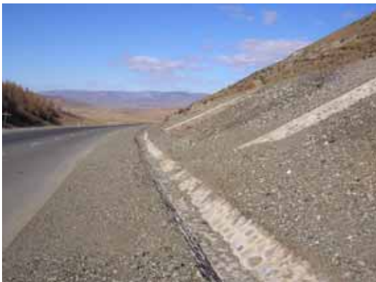
東部地域道路 (排水溝、日本の無償援助で実施)
