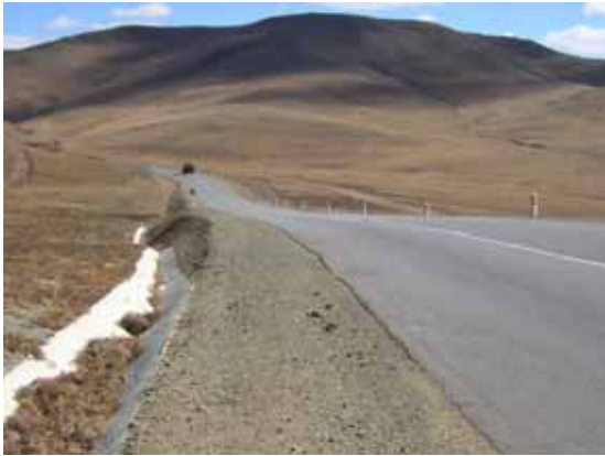
東部地域道路 (現地業者施工区間)
