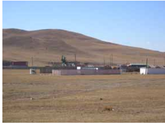
東部地域建設用プラント施設 (アスファルト及び砕石、無償援助で建設)
