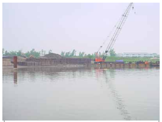
⑫ 紅河橋事業建設現場 (3)
