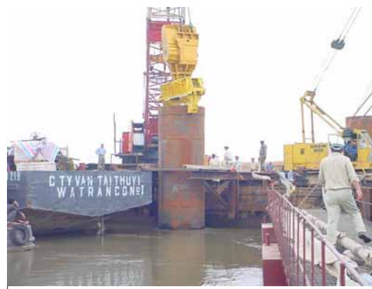
⑪ 紅河橋事業建設現場 (2)
