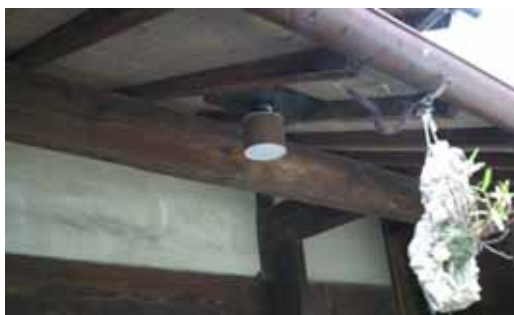
図4 赤外線マーカの設置状況
