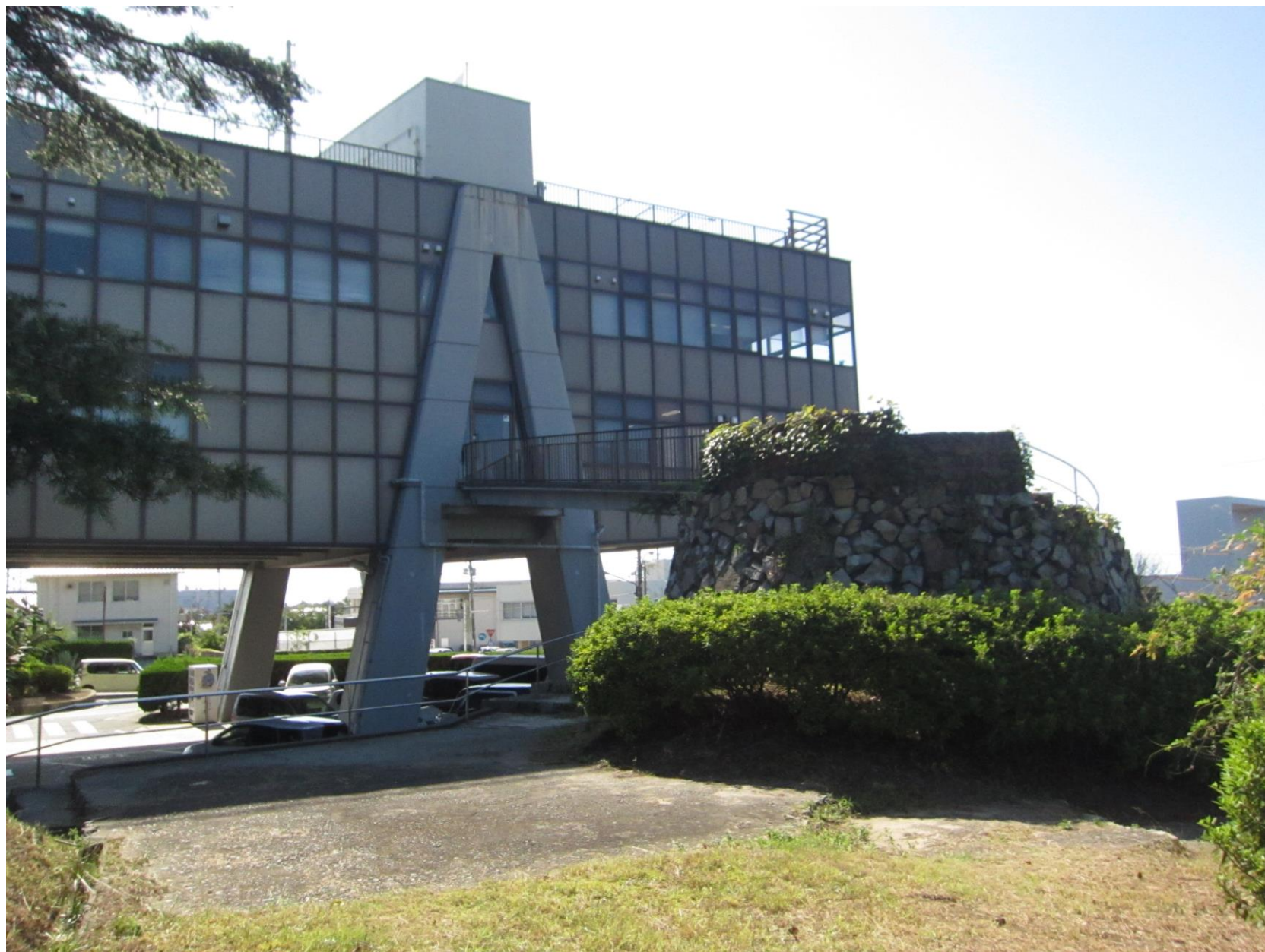
庁舎東面（A棟）
