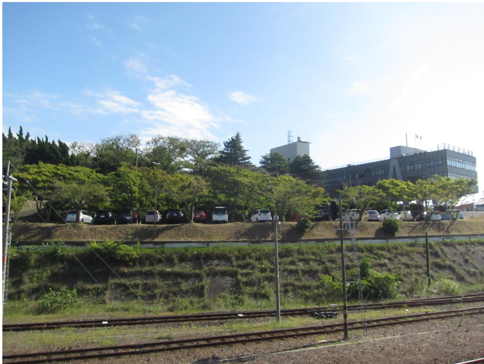
遠景（庁舎東面）
