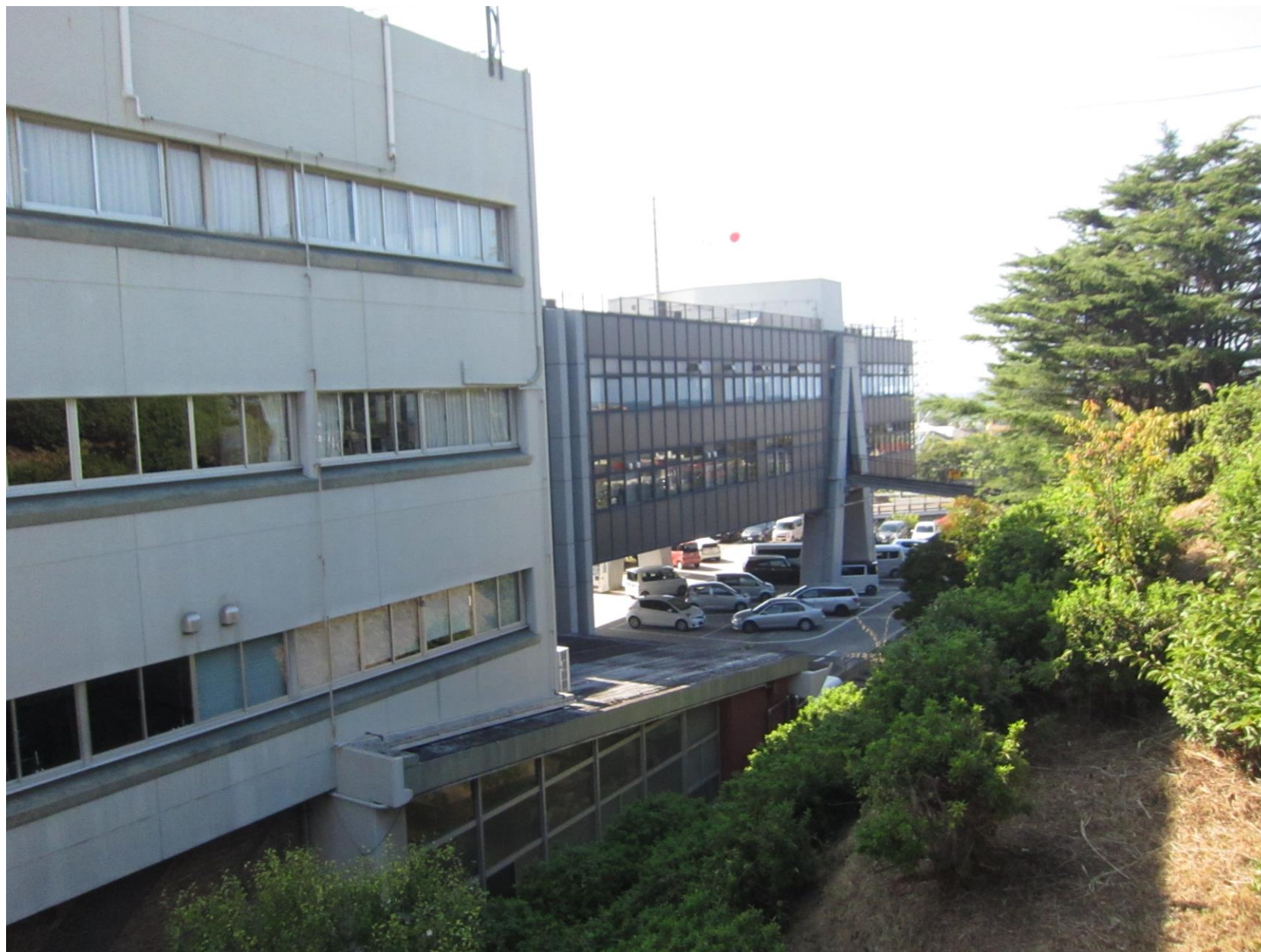
庁舎東面（手前：B棟、奥：A棟）
