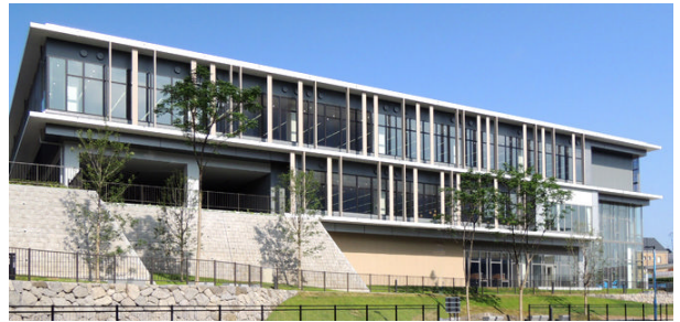
八幡西図書館外観
