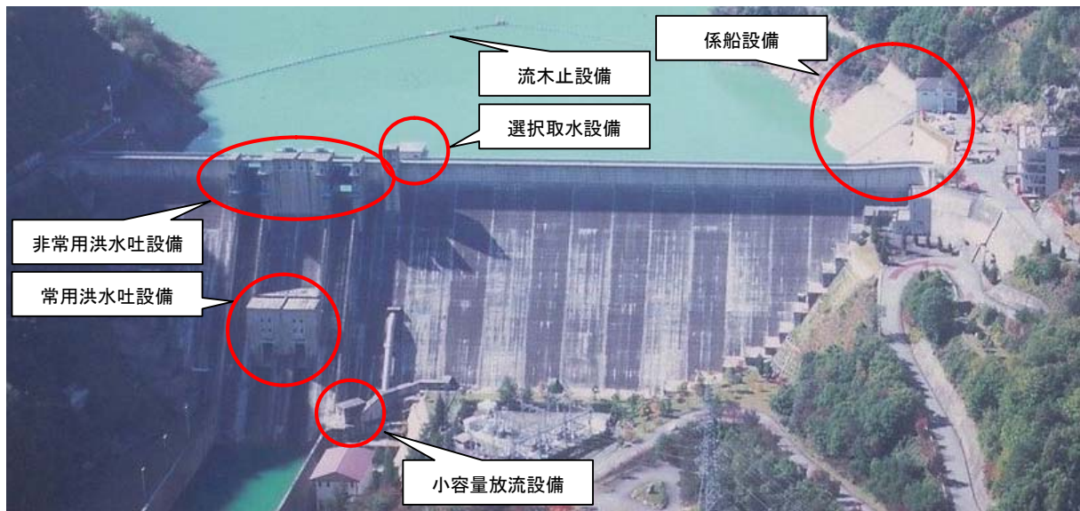
図 1.2-1 ダム用ゲート設備等(事例)
