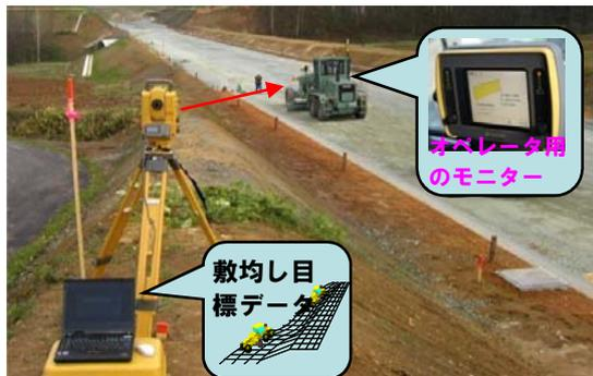
ブルドーザやモータグレーダの進行方向・位置と排土板の傾き・標高を計測し、あらかじめ入力した目標高さや傾斜に対する差分をリアルタイムに計算し、排土板を目標値に自動制御するシステム
