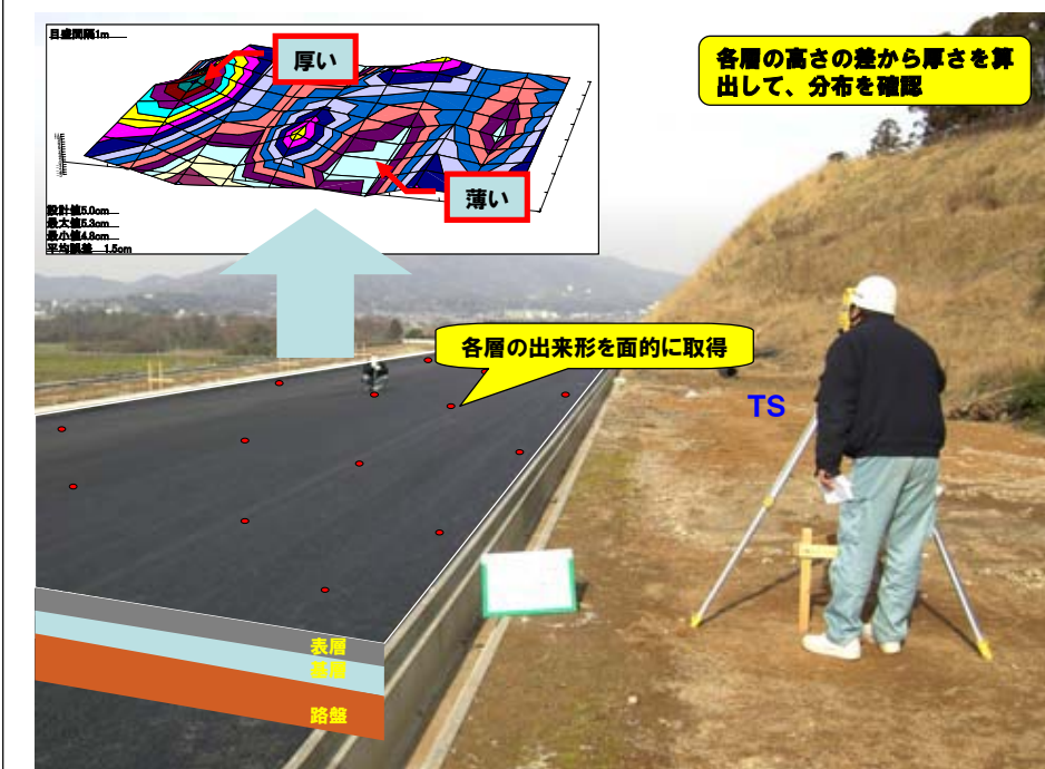
TSを用いた出来形確認技術(厚さ)(例)
