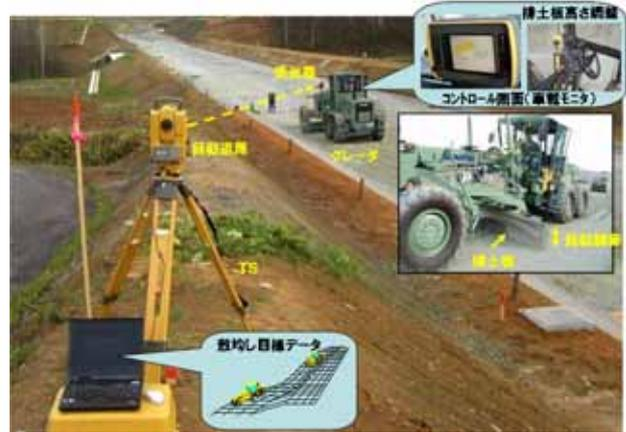
ブルドーザやモータグレーダの進行方向・位置と排土板の傾き・標高を計測し、あらかじめ入力した目標高さや傾斜に対する差分をリアルタイムに計算し、排土板を目標値に自動制御するシステム。
