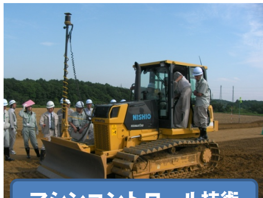
マシンコントロール技術
