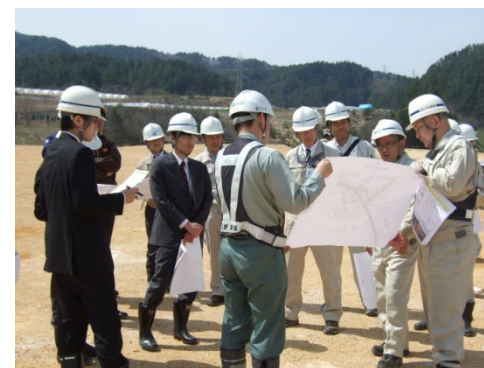
(高山) 上切道路建設工事
