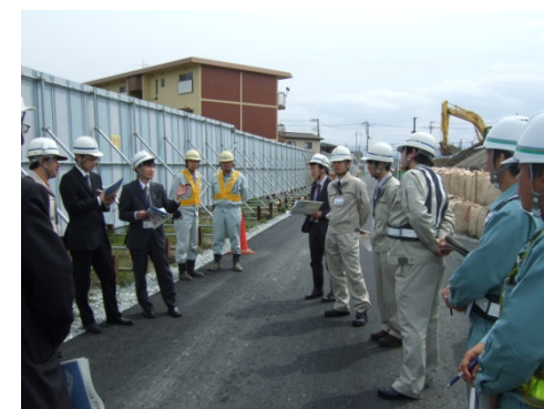
(沼津) 八ツ溝高架橋仁田下部工事
