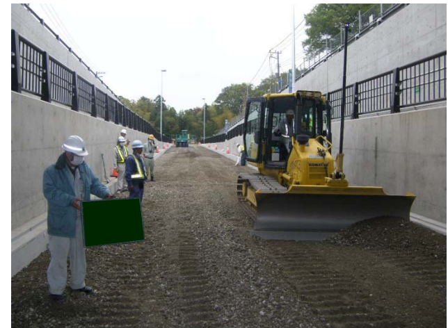
E工事の現場状況(写真)
