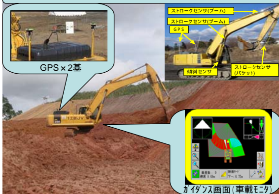
バックホウ掘削工のマシンガイダンスシステム
