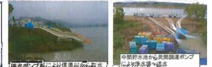
排水ポンプ車により信濃川から取水
