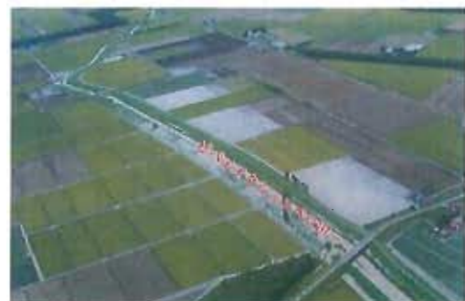
写真1 内水氾濫状況
