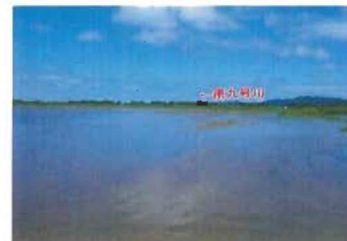
写真5 内水氾濫状況
