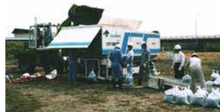
土のう造成状況
