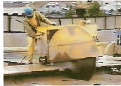
コンクリートカッター 床版部切断作業
