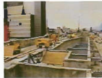
ウォールソー 高斜度床版部切断作業
