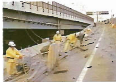
ウォールソー 高斜度床版部切断作業
