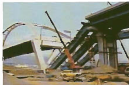
コンクリートカッター床版部切断作業 走行補助にウインチ使用
