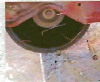
エンジンカッター レスキュー仕様 地震災害時 活用例
