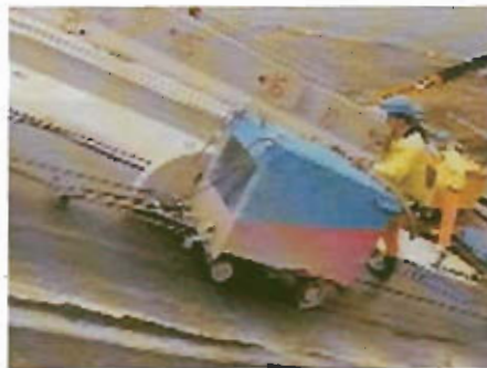
コンクリートカッター床版部切断作業 走行補助にウインチ使用
