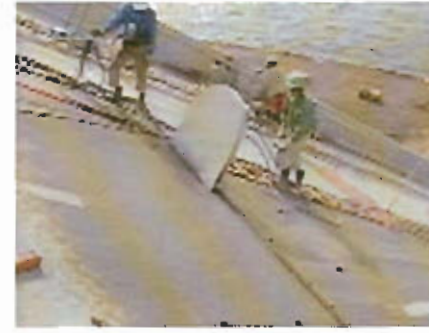
ウォールソー 床版部横断方向切断作業
