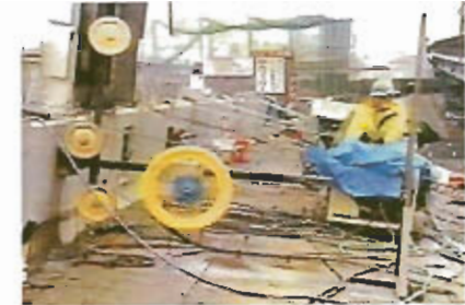
ワイヤーソー 高欄部切断作業
