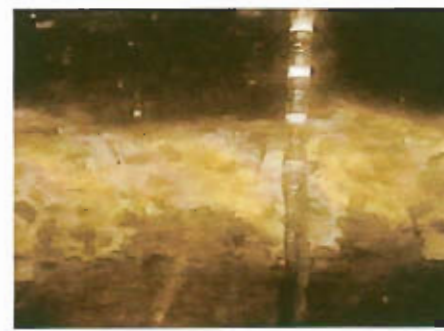
ワイヤーソー工法 水中切断 自走型 37kW×2
