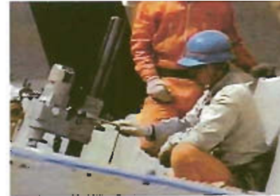
コアドリル 切断物吊孔 開孔作業
