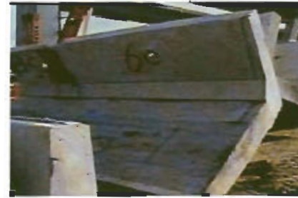
ウォールソー 床版部横断方向切断作業
