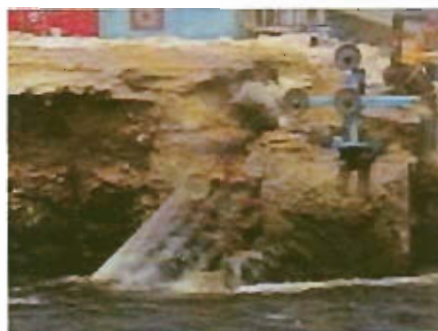
ワイヤーソー工法 水中切断 自走型 37kW×2
