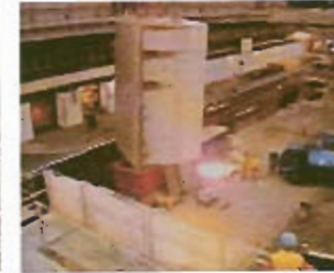
ウォールソー 高斜度床版部切断作業
