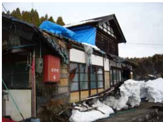
写真-6 一部損壊した屋根 （ふくい災害ボランティアネット提供）
