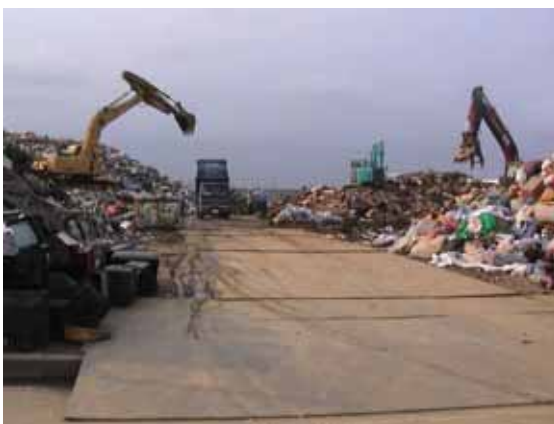
写真-13 油圧ショベルによる災害復旧状況（見附市提供）
