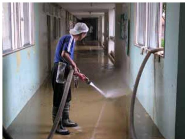
写真-22 水槽付消防自動車による災害復旧状況 (見附市提供)
