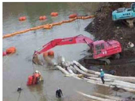
写真-2 芋川河道閉塞箇所の排水作業 (北陸地整ホームページより)
