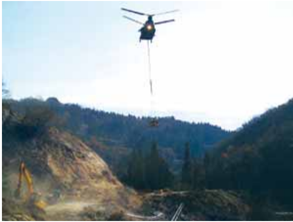
写真-15 資機材を自衛隊ヘリコプターで空輸 (北陸地方整備局ホームページより)
