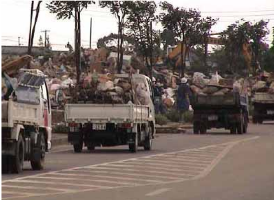
写真-12 軽ダンプ・2t ダンプによる瓦礫運搬状況（見附市提供）
