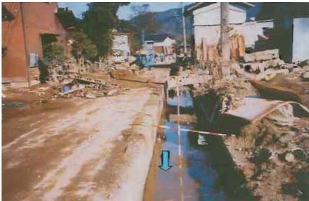
写真-27 浸水被害後の側溝（豊岡市提供）
