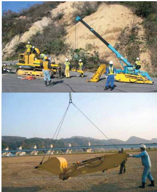
写真-23 分解空輸され現地で組立てる油圧ショベル(北陸地方整備局提供)
