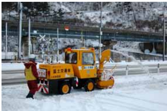
写真-19 中浜歩道除雪ボランティアの会活動の様子（新潟国道事務所提供）
