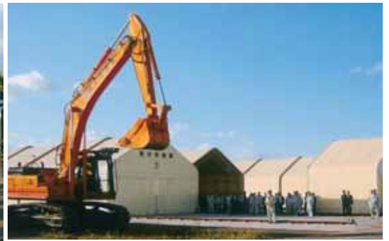
写真-41 遠隔操縦油圧ショベル
