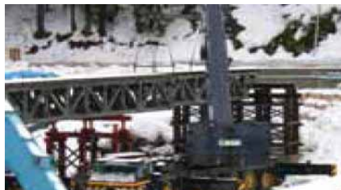
既存の応急組立橋は 1 週間ほどの施工期間が必要
