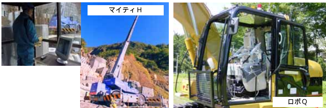
写真-31 遠隔操縦型建設機械（北陸地方整備局・九州地方整備局提供）
