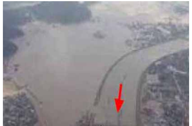
写真-3 兵庫県豊岡市円山川の破堤状況 （豊岡河川国道事務所ホームページより）
