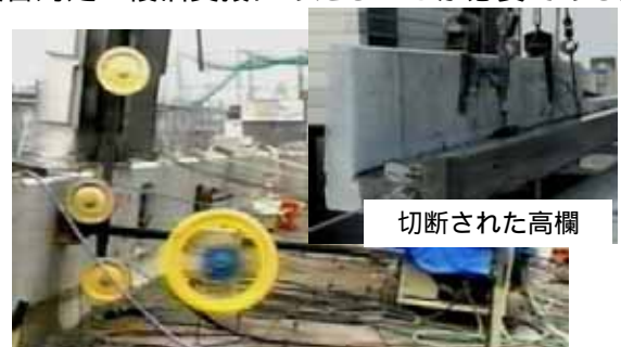
ワイヤソー高欄部切断作業
