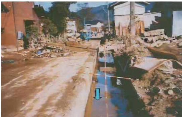
写真-28 浸水被害後の側溝（豊岡市提供）
