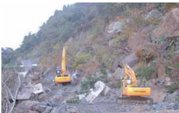
写真-1 無人化施工機械による被災者救出状況 (長岡市妙見地先：北陸地整ホームページより)
