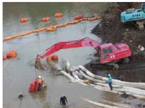
写真-2 芋川河道閉塞箇所の排水作業 (北陸地方整備局ホームページより)
