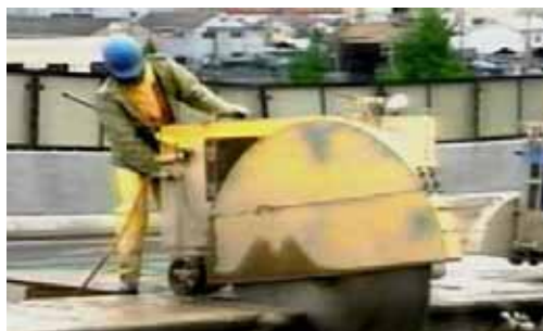
コンクリートカッター床版部切断作業
