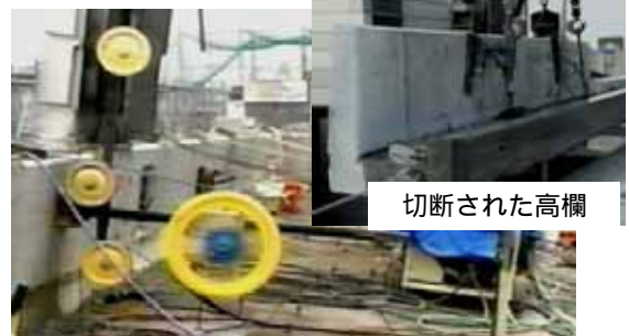
ワイヤソー高欄部切断作業
