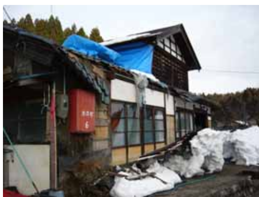
写真-6 一部損壊した屋根 （ふくい災害ボランティアネット提供）
