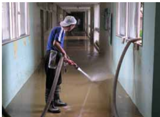
写真-37 水槽付消防自動車による災害復旧状況 (見附市提供)
