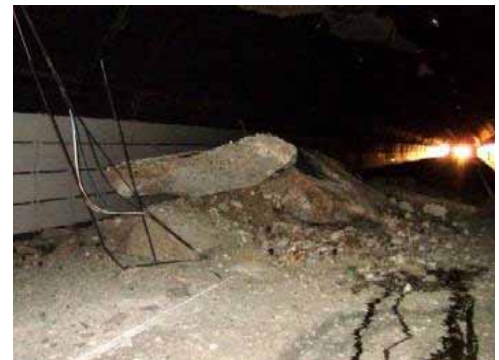
写真-26 総量 50t のコンクリート塊が崩落した和南津トンネル（北陸地方整備局提供）
