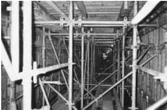
写真 7 くさび結合支保設置状況
