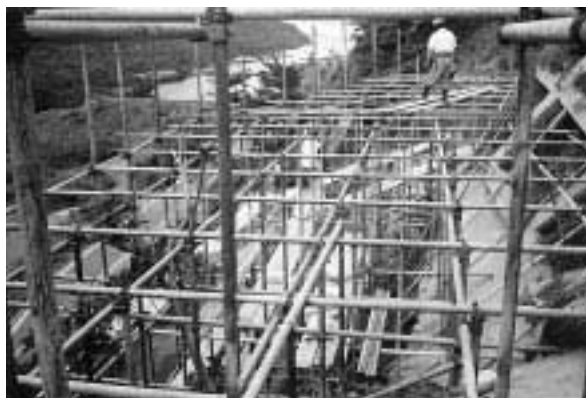
写真 2 単管足場設置状況
