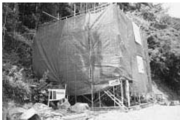
写真 4 安全ネット設置状況
