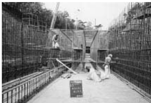
写真 6 枠組支保設置状況
