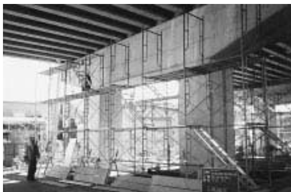
写真 1 枠組足場設置状況
