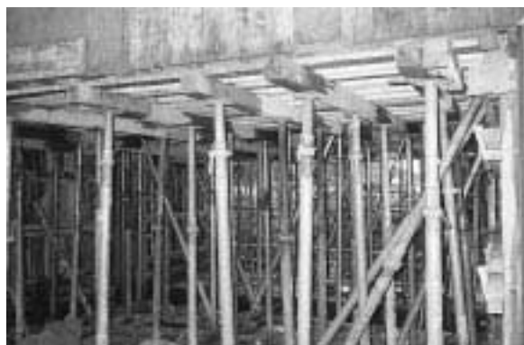
写真 5 パイプサポート支保設置状況
