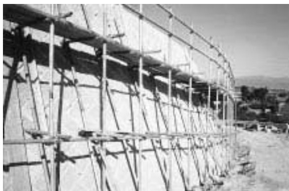
写真 3 単管傾斜足場設置状況
