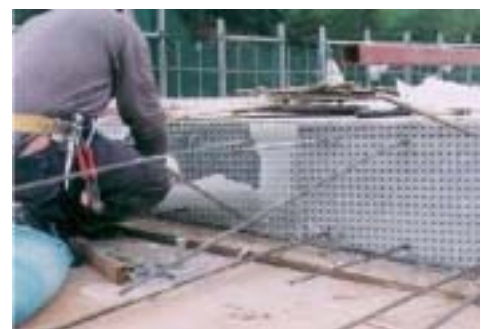
シートの取外しの状況
