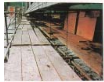
従来の吊り足場
