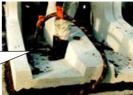
セメントミルク注入状況
