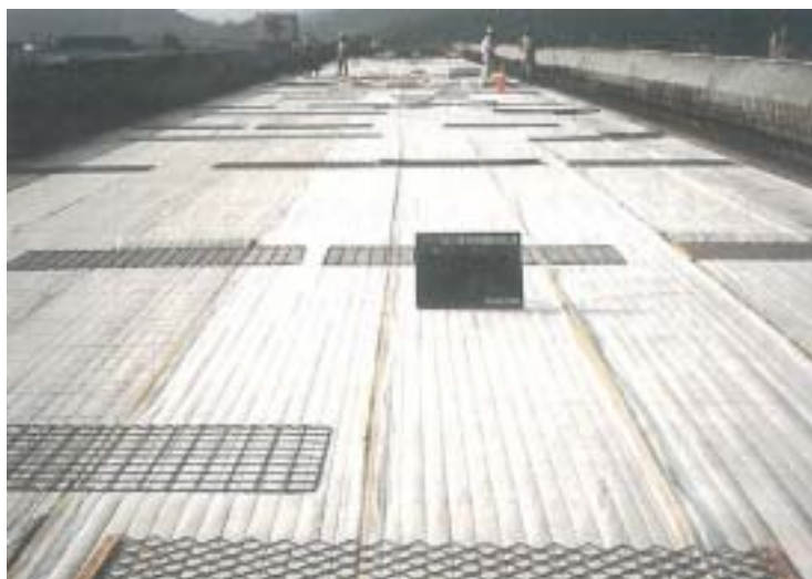
マットの敷設状況
