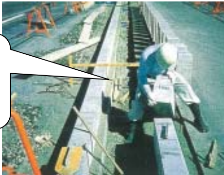
ブロックの敷設状況 (人力)
