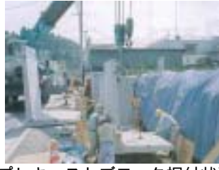
プレキャストブロック据付状況
