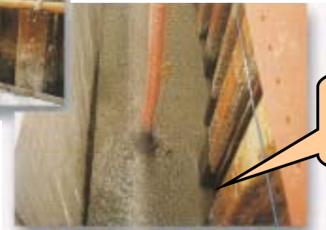
山止め壁と地下構造物間の埋戻し
