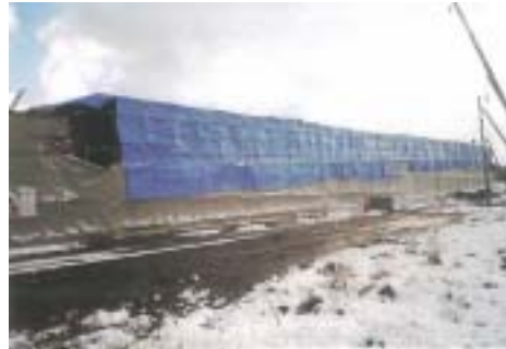
冬期養生の状況
