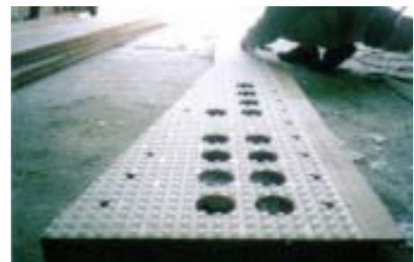
シートの取外しの状況
