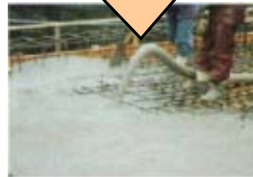
打ち込み状況
