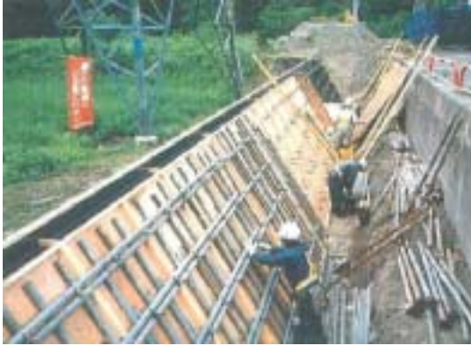
従来工法の施工状況
