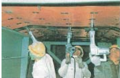
鋼板の取り付け状況
