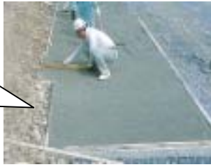
敷モルタル施工状況
