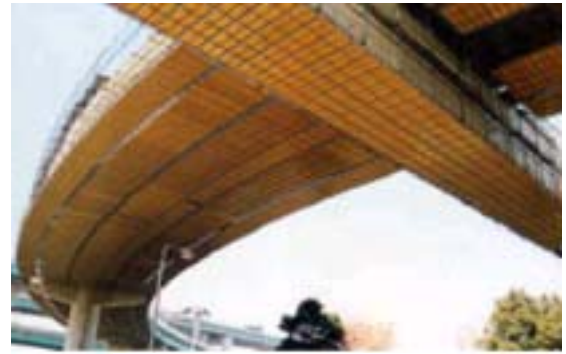
本事例の吊り足場の全景
