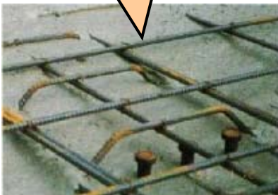
鉄筋通過状況
