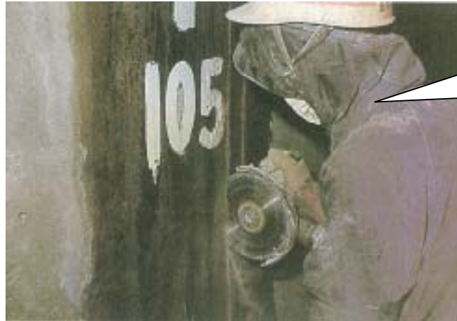
コンクリートの切断状況
