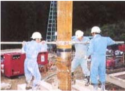
継手部の接続
