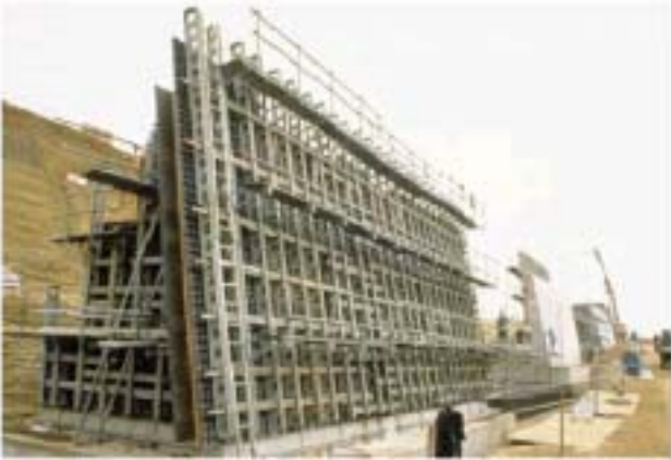
大型型枠の施工例
