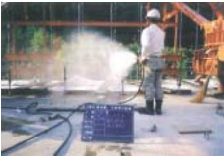
散水養生の状況
