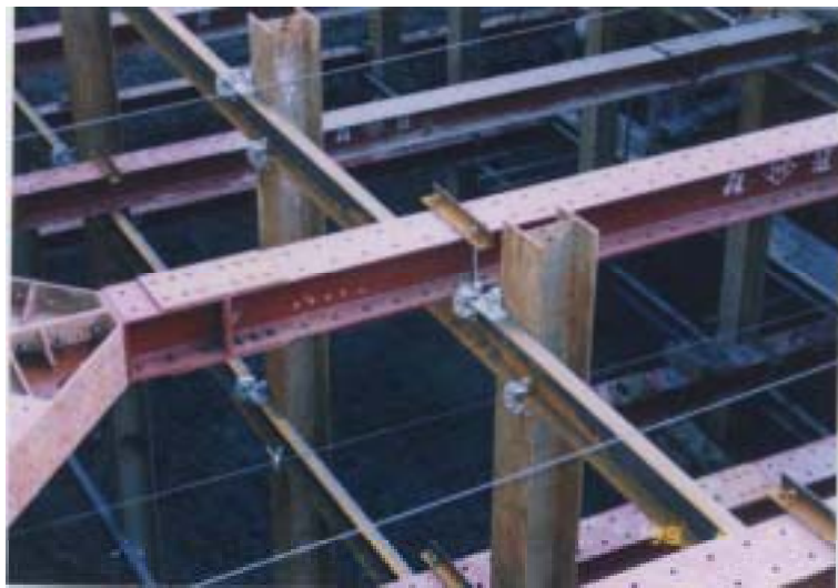
山留め材に使用した例
