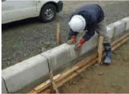
目地詰め状況
