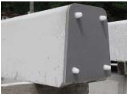
プレート材添付状況 (位置決めピンタイプ)
