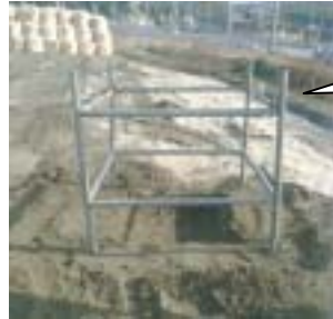
単管パイプによる製作枠
