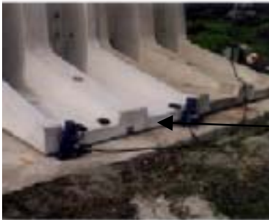
擁壁据付状況
