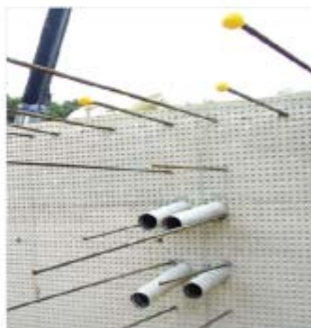
鉛直打継ぎ目の状況
