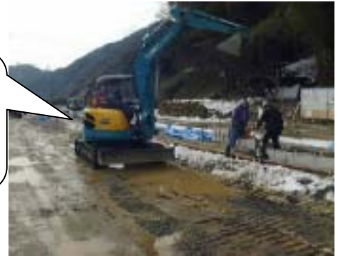
ブロックの敷設状況 (クレーン機能付きバックホウ)
