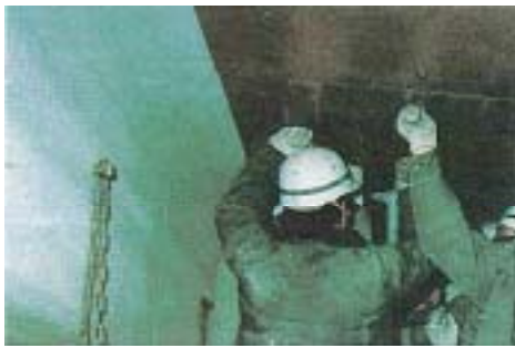
鋼板の取り付け状況
