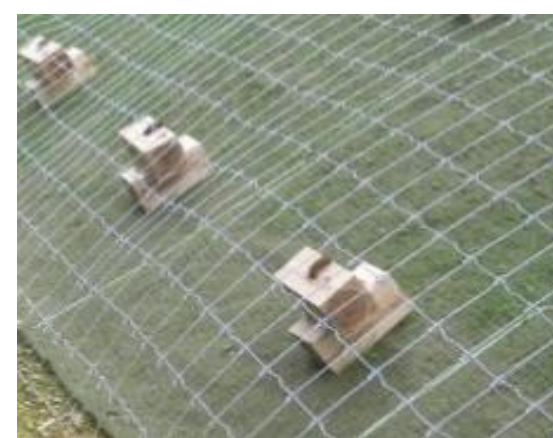
ラス網を角材により浮かせて設置
