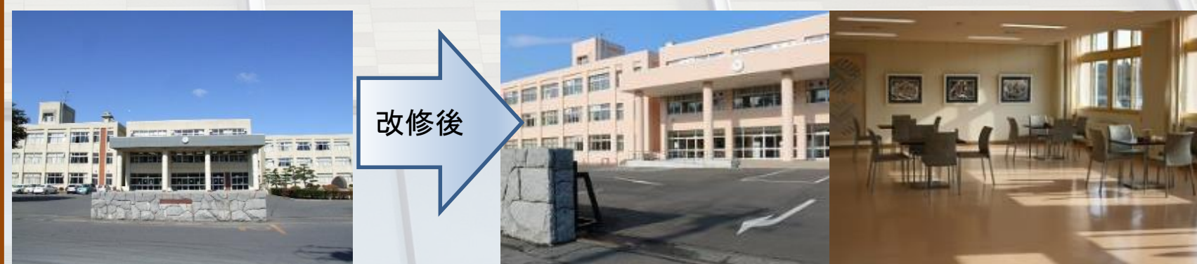
背景写真：県庁舎外壁の改修済の部分
