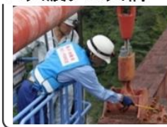
ケーブルの力バー部の腐食
